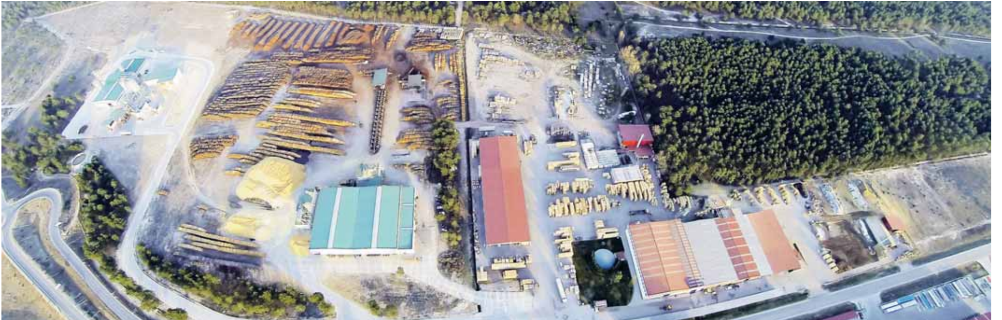
Instalaciones de 'Pallet Tama' y 'Naturpellet' en la localidad segoviana de Sanchonuño.
